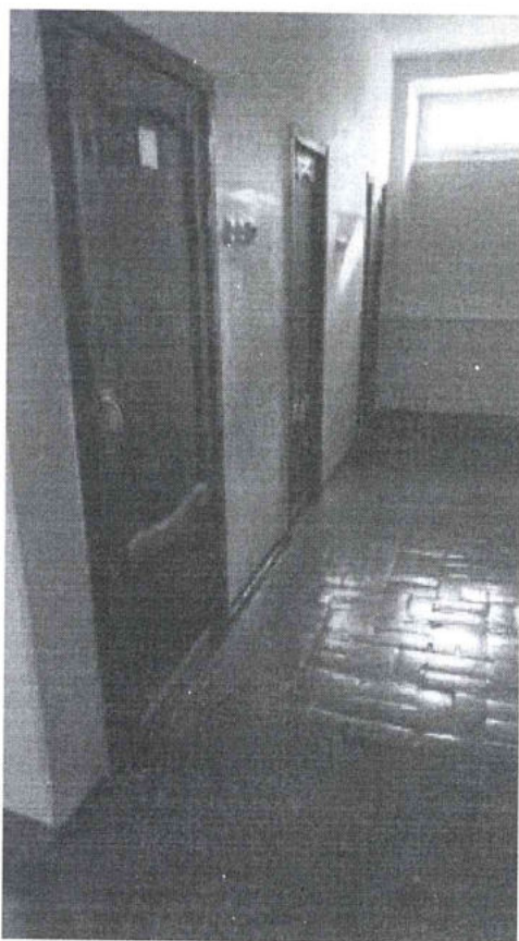
фото № 22 входные двери в туалеты
