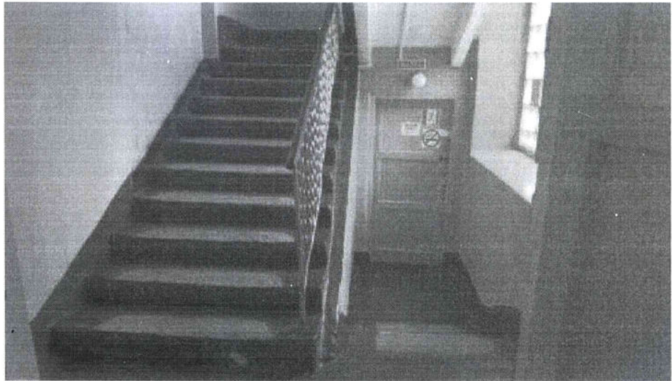
фото № 19 лестница (внутри здания)
